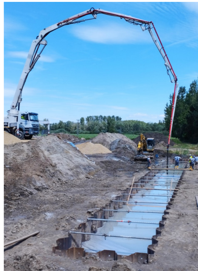
Az ideiglenes körtöltés kialakítása és a víz alatti beton készítése a Börcsi zsilipnél
