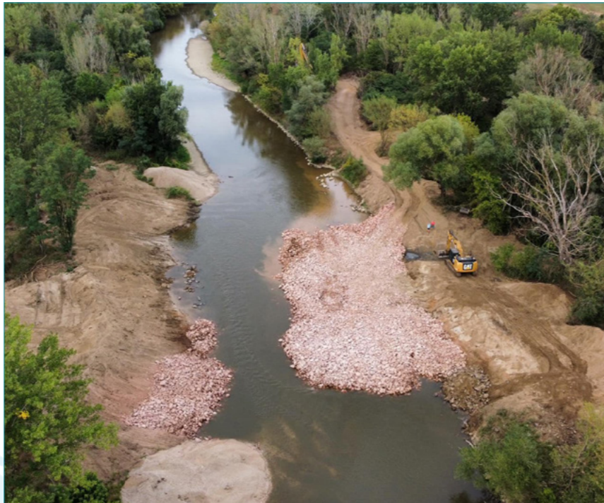
Pápcsi fenékküszőb építés közben
