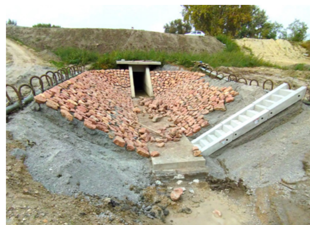
Zsilip vasbeton szerkezetének építése és mederburkolat kialakítása vákuumkutas víztelenítéssel
