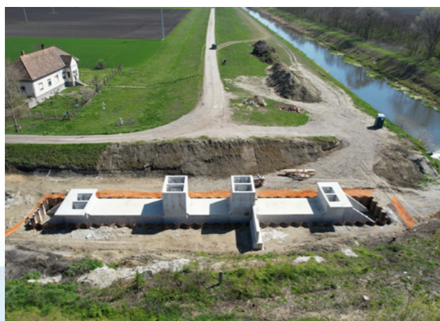
Zsilip vasbeton szerkezetének építése és mederburkolat kialakítása vákuumkutas víztelenítéssel
