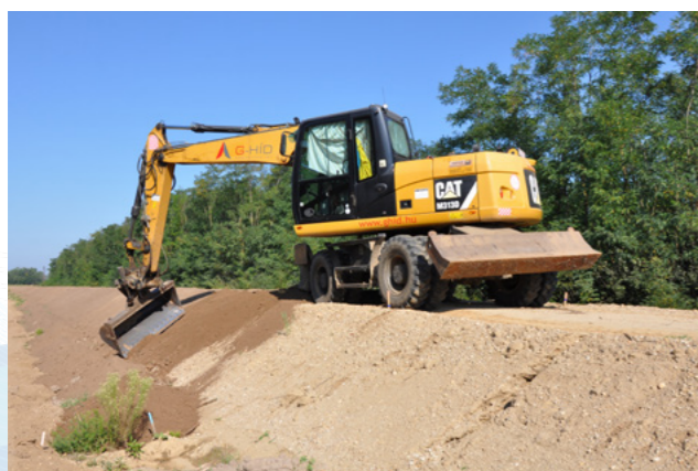
Települési másodrendű védvonal építés közben és a megvalósulás után
