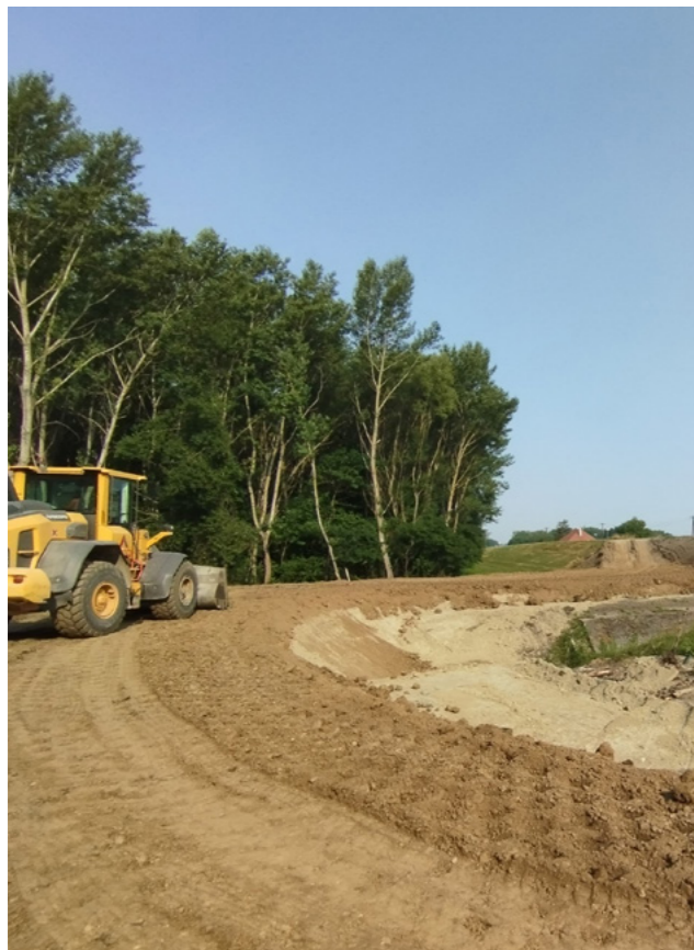
Az ideiglenes körtöltés kialakítása és a víz alatti beton készítése a Börcsi zsilipnél
